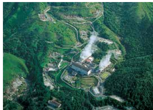
八丁原発電所
